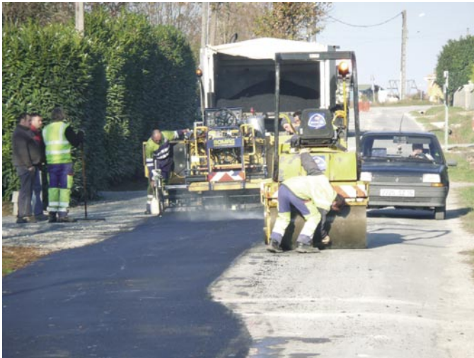
Travaux de remise en état des voies suite à l'enfouissement de l'assainissement
